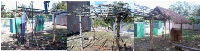
Figura 1. Construcción de palapas para las pruebas con medidas de 2x2 mts.
