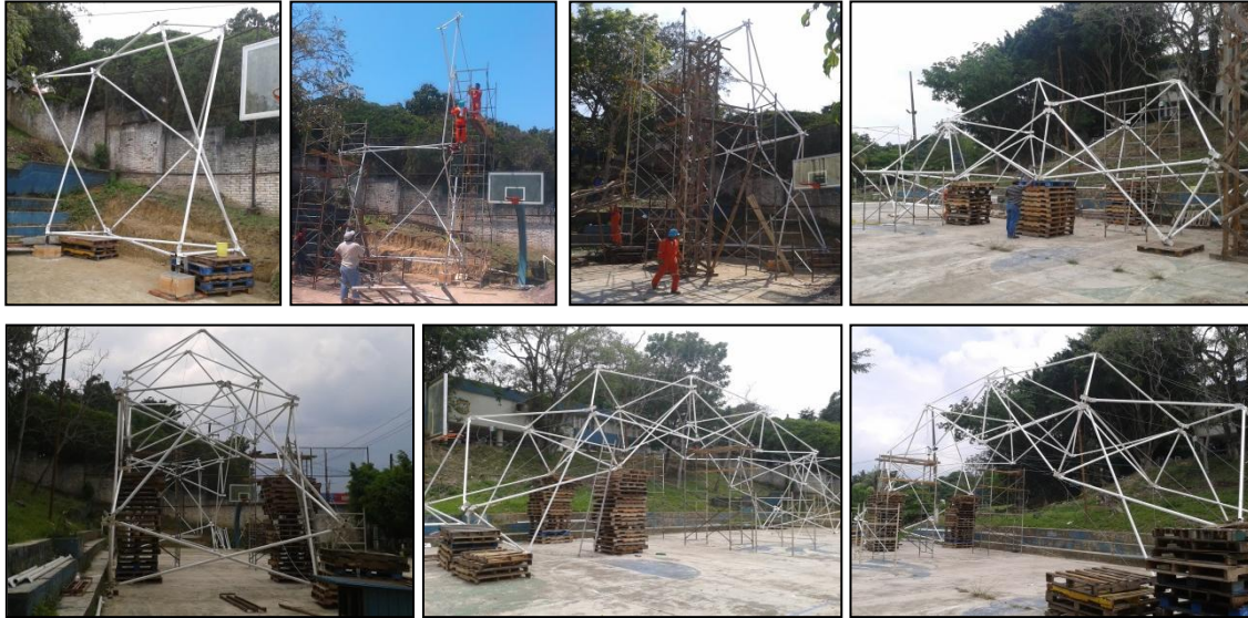
Figura 32 al 38. Evidencia Fotográfica del Prototipo: El segundo ensamble se realiza para formar el arco de la cubierta retráctil, este contara con 8 módulos conectados para comprobar fallas geométricas y constructivas del mismo sistema. Fuente: Estancia Post Doctoral Morales, 2012.
