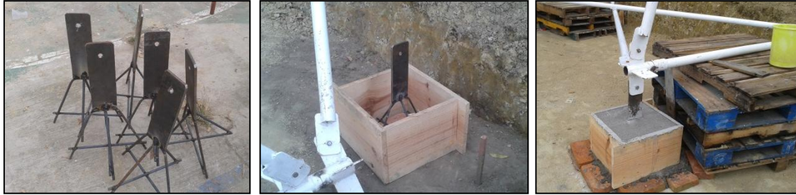
Figura 23 al 31. Evidencia Fotográfica del Prototipo: Se desarrolló el armado de la estructura para verificar si ensamblan todas las piezas esto ayudo a corregir algunos errores y desarrollar una estrategia constructiva de armado. Fuente: Estancia Post Doctoral Morales, 2012.
